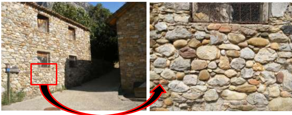
Imagen II y III: Fachada de casa en Badián donde se observan clastos de muy diferente litología y edad, con señal indicadora de la dirección del camino.
