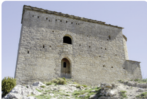
Figura 9. Ermita de San Emeterio y San Celedonio. La entrada original era por la ventana que se observa sobre la actual puerta de acceso.
